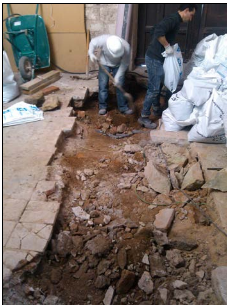
FOTO 3. Procés d'excavació de la Rasa 1000.
