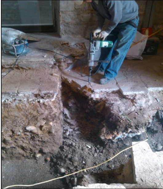
FOTO 5. Procés de treball Rasa 2000
