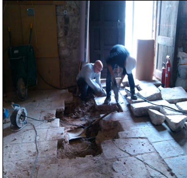
FOTO 2. Vista de l'edifici de la Pia Almoïna
