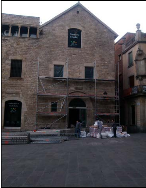
FOTO 1. Vista de l'edifici de la Pia Almoïna
