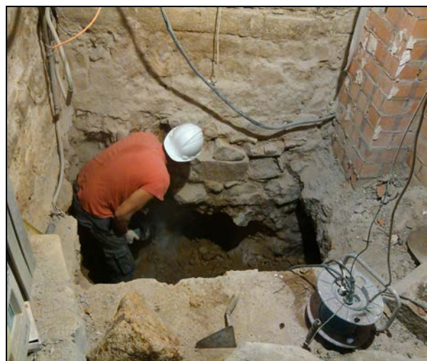
FOTO 8. UE 4000. Practicant obertura a la façana
